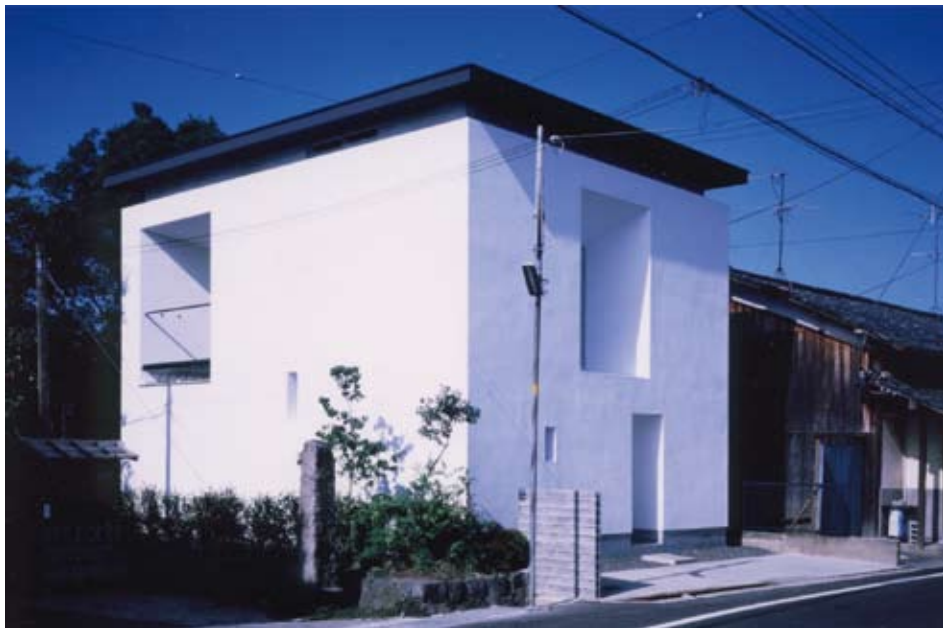
南西側からの全景、手前は左側奥の神社につづく参道
